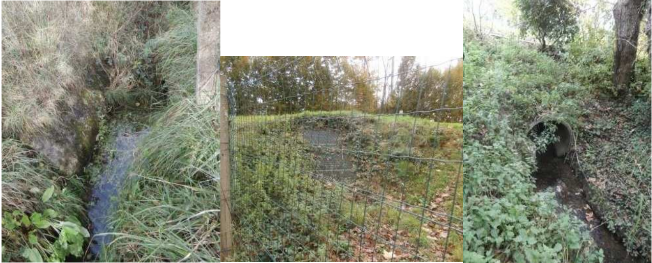
Figure 16 : Fossé, dalot et fin du busage du ruisseau
