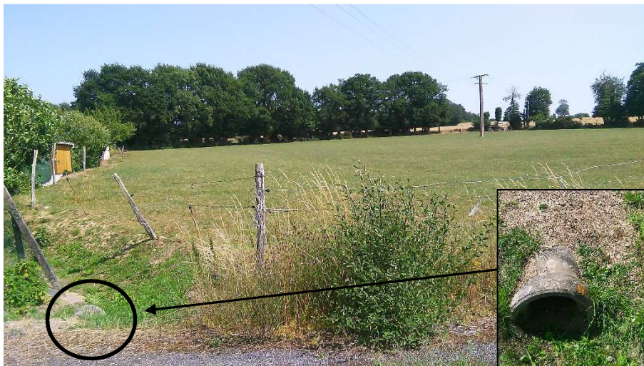
Figure 15 : Conduite Ø600 mm présente au point bas au Nord-Ouest du projet
